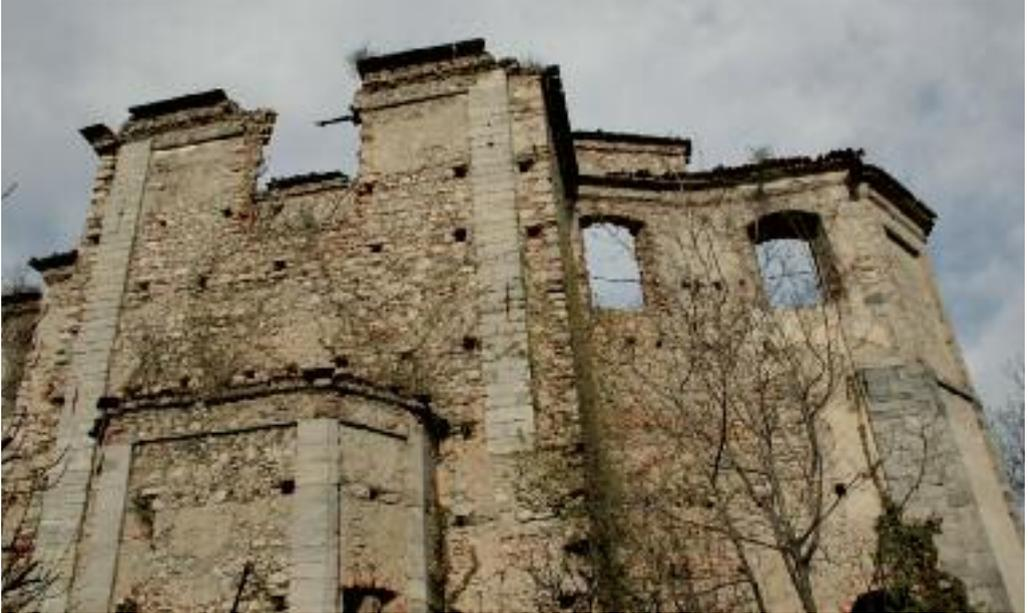
Negli anni novanta la condizione di degrado della chiesa di San Michele era ormai talmente avanti da far prevedere come imminente il crollo di una parte della struttura architettonica, soprattutto nella parte alta.
